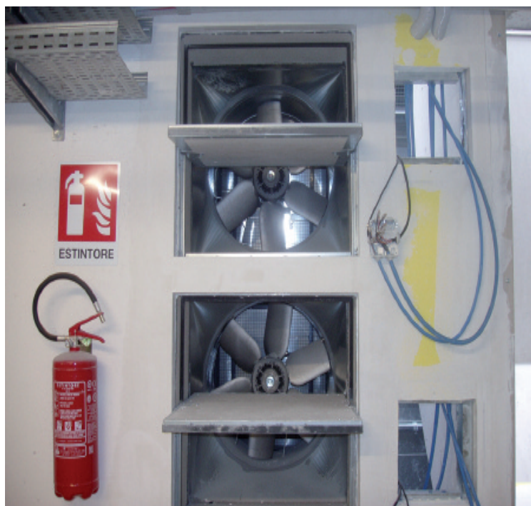
Gli estrattori di fumo e calore assiali a due velocità durante una fase dell'installazione
